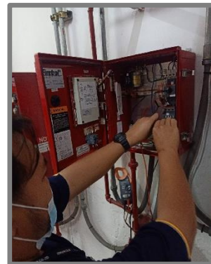
รูปที่ 27 การตรวจสอบระบบป้องกันและเตือนอัคคีภัย
