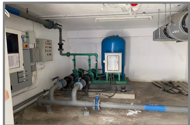
รูปที่ 8 ถังสำรองน้ำใช้รดน้ำ
