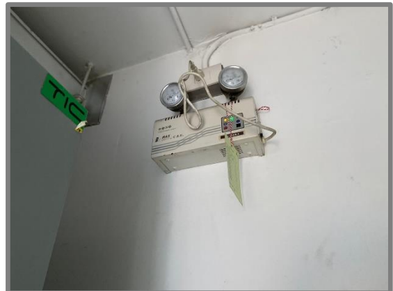
รูปที่ 17 หม้อแปลงไฟและไฟสำรอง
